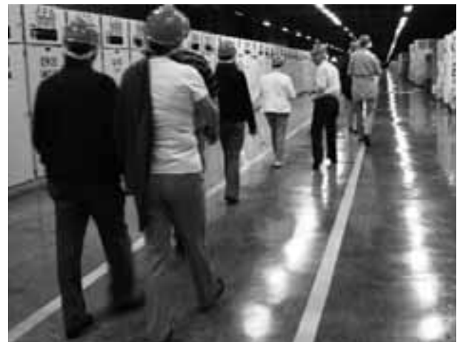
Exkursion: In der Schaltzentrale des Wasserkraftwerkes Itaipu
