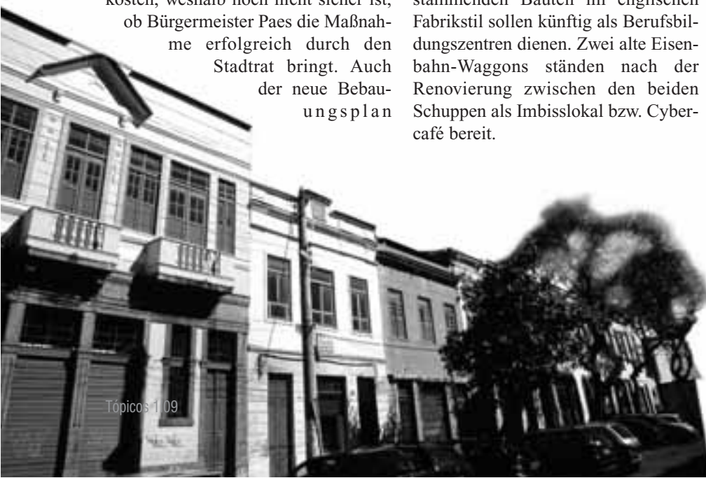
Noch aus Rios Kolonialzeit stammen viele Häuschen im Hafenviertel
