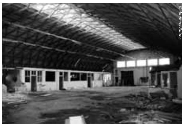
Lamellenhalle auf dem Junkalorgelände in Dessau, 2007
