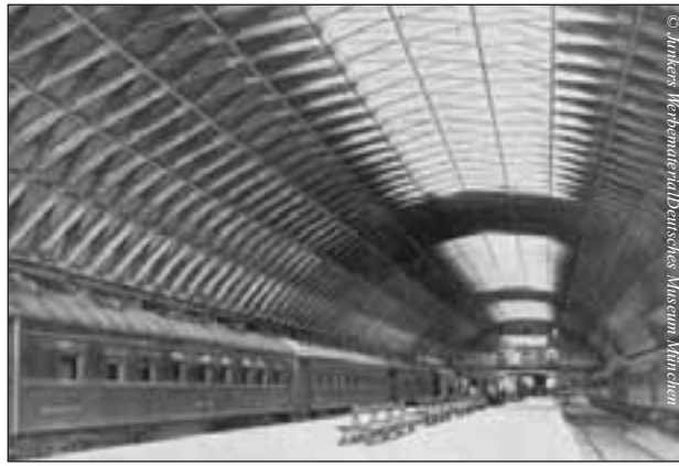
Lamellenhalle des Estação Roosevelt, um 1930
