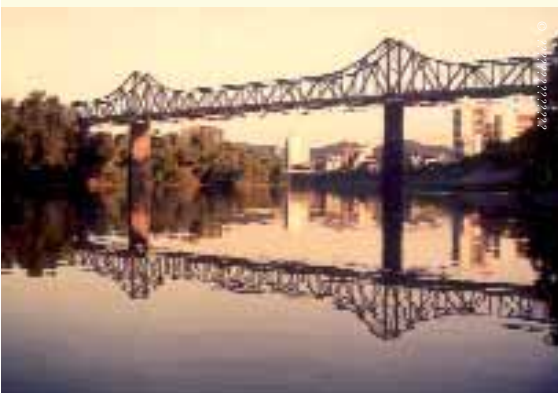
Ponte de ferro
