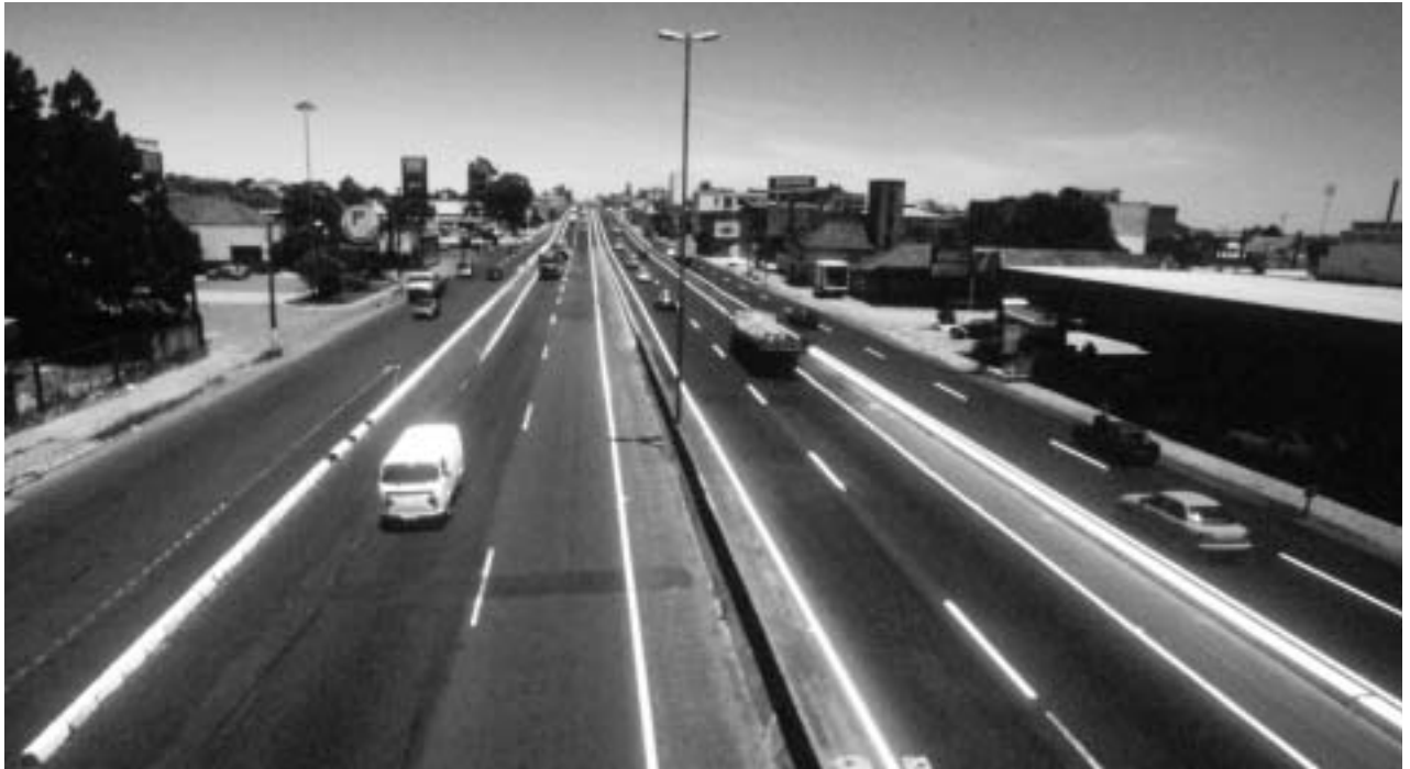
Der Ausbau der „Rodovia do Mercosul“ beseitigt Engpässe und Gefahrenpunkte für Lkw-Transporte.
